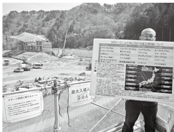
▲ ラグビーワールドカップ 2019 釜石建設現場
