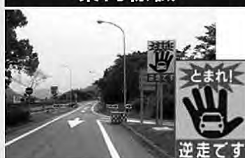
逆走の注意喚起標識 (サービスエリアへの流入ランプ)
