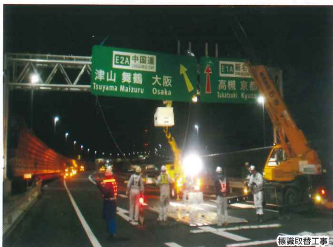
標識取替工事
