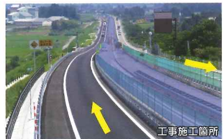
施工例:切替後
