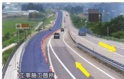
施工例:切替前
