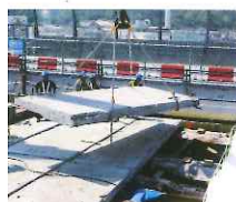
老朽化した床版の撤去
