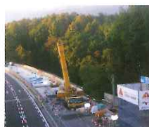
床版取替工事 全景
