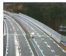
床版取替完了後
