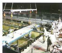
新しい床版の設置
