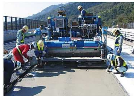
配筋・増厚コンクリート打設
