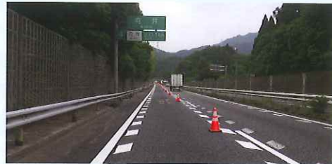
〔維持修繕工事〕
