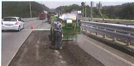
〔橋梁補修工事〕
