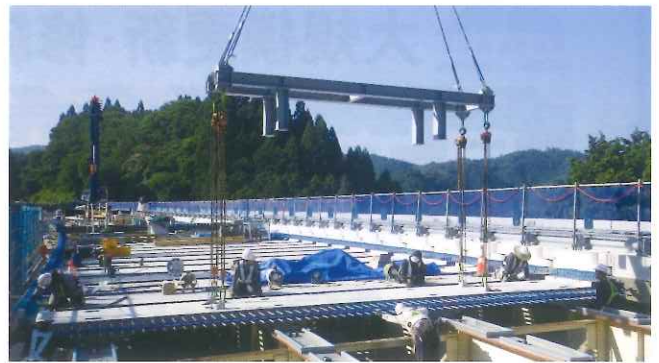
プレストレストコンクリート床版架設
