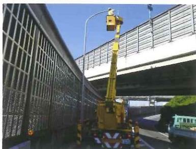
道路照明設備点検
