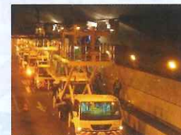
構造物点検状況①
