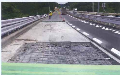
橋梁の舗装下のコンクリートを補修します。
