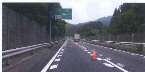
〔維持修繕工事〕
