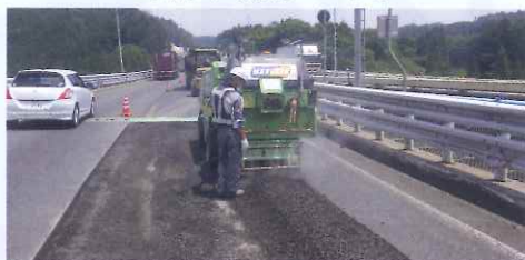
〔橋梁補修工事〕
