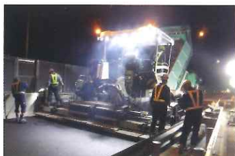
舗装補修工事
