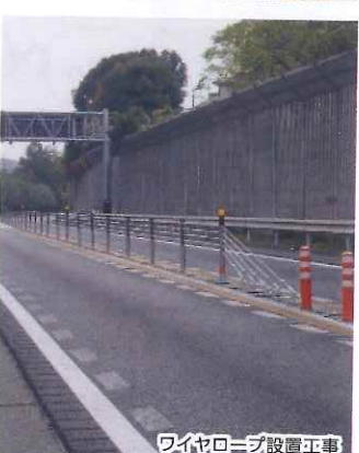
ワイヤロープ設置工事
