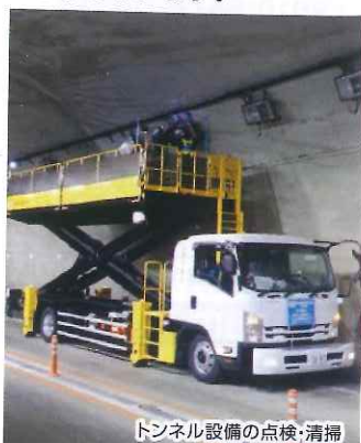
トンネル設備の点検・清掃
