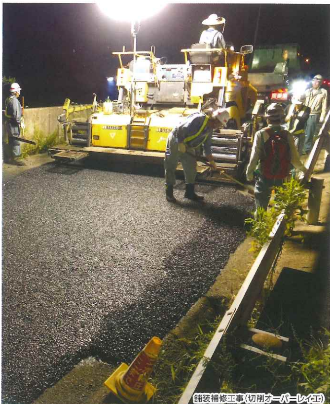
舗装補修工事(切替オーバーレイ)
