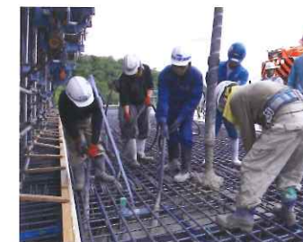
<現場打ち床版の施工状況>
