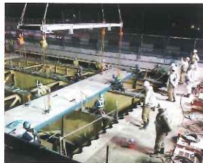
新しい床版の設置
