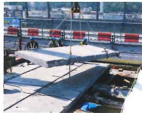
老朽化した床版の撤去
