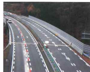
床版取替完了後
