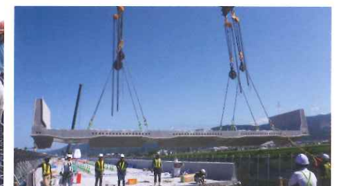
<プレキャストコンクリート床版の施工状況>
