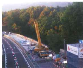
床版取替工事 全景
