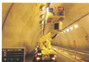
トンネル照明 清掃・点検
