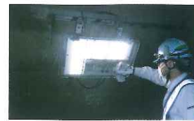
トンネル照明の点検
