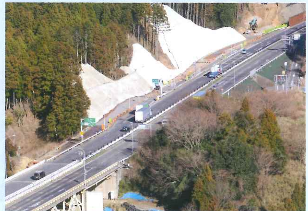
久我IC改良工事（工事状況写真）
