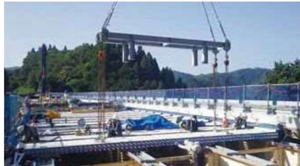
プレレストコンクリート床版架設
