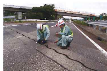
橋梁伸縮装置の点検
