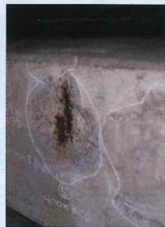
舗装下のコンクリートの劣化状況
