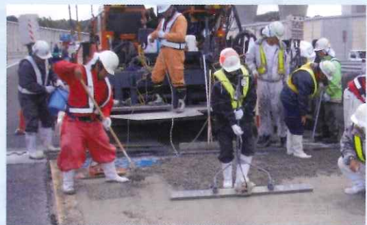
舗装下のコンクリートの修復状況
