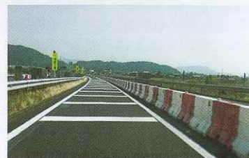
薄層舗装(白線部分)
