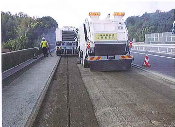
〈補修舗装工事(イメージ)〉
