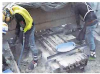
① 既存の橋梁伸縮装置を撤去
