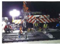
③ 新しい橋梁伸縮装置の設置
