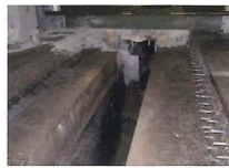
② 橋梁伸縮装置の撤去後の状況
