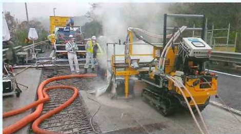
〔橋梁補修工事〕
