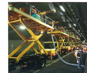
トンネル設備点検
