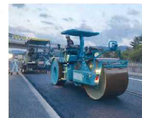
舗装施工状況
