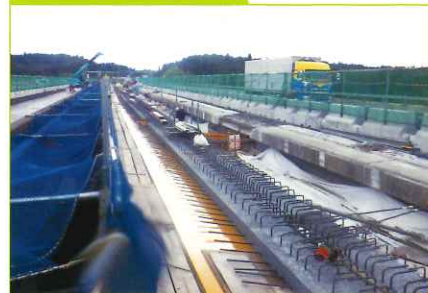
橋梁工事 拡幅箇所
