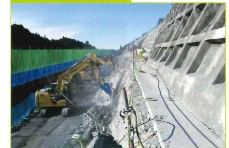
土工工事 拡幅箇所
