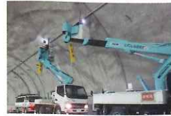
水噴霧設備の設置作業状況
