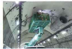
ジェットファンの設置作業状況
