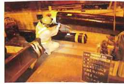
水路管の取替作業状況
