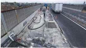
床版補修状況
