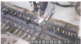
伸縮装置取替工事(イメージ)
