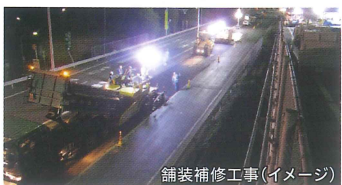
舗装補修工事(イメージ)
