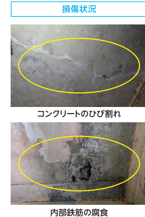
内部鉄筋の腐食
