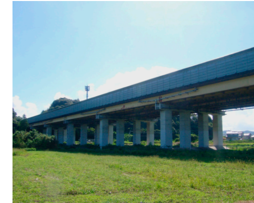
菅ヶ谷高架橋
