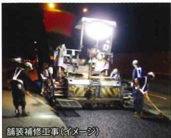
舗装補修工事(イメージ)
