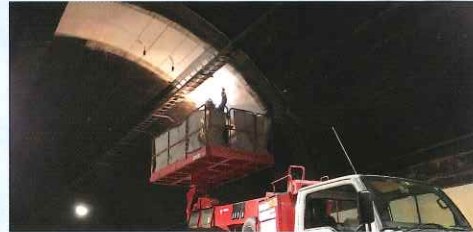
〔トンネル補修工事〕
