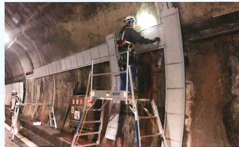
コンクリート壁面の補修や漏水対策を実施します。
