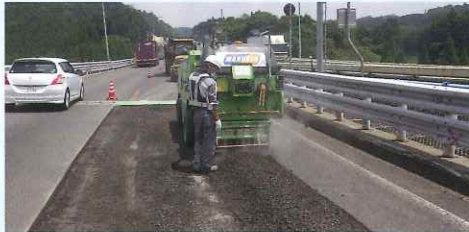
〔橋梁補修工事〕
