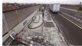
床版補修状況
