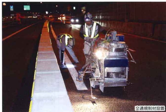
交通規制材設置
