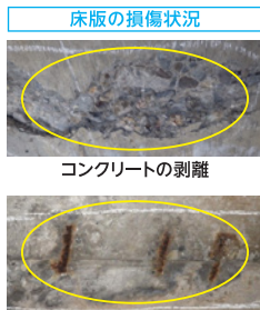
内部鉄筋の露出
