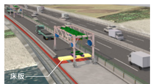
移動床版架設機による分割断面床版取替（今回）
