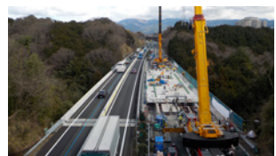
大型クレーンによる全断面床版取替（従来）
