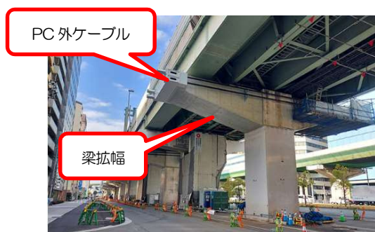
コンクリート橋脚の梁拡幅状況
