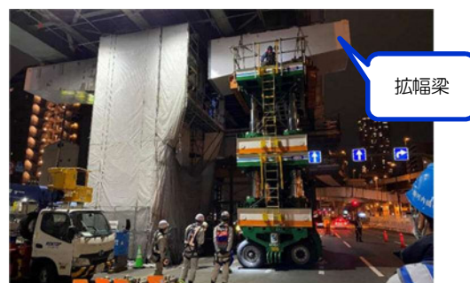
鋼製橋脚の拡幅梁架設状況
