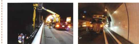
橋梁点検車を用いた橋梁下面および橋桁の点検 トンネルの側壁清掃
