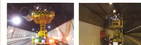
トンネルジェットファン点検 トンネル照明設備点検
