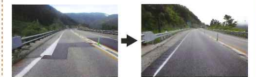
施工前 施工後
