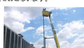
道路照明設備の点検
