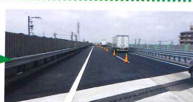
⑥ 外側線を設置して完成です
