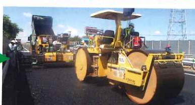
⑤ 新しい舗装を設置します※
