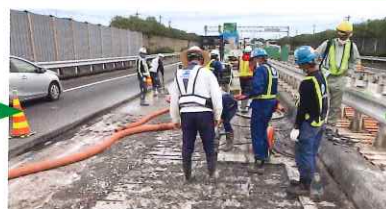
② 床版上面の損傷したコンクリートを撤去します
