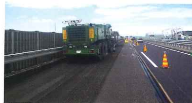
① 既存の舗装を撤去します
