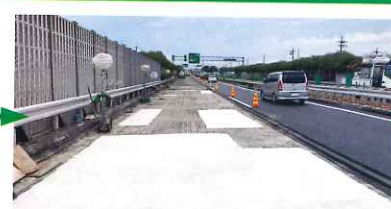
③ 撤去した部分にコンクリートを打設します※
