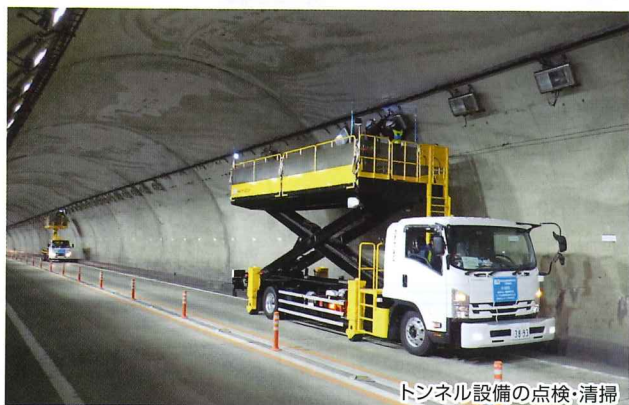
トンネル設備の点検・清掃
