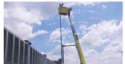
道路照明設備の点検
