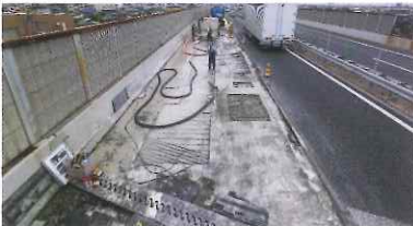
舗装・床版補修状況
