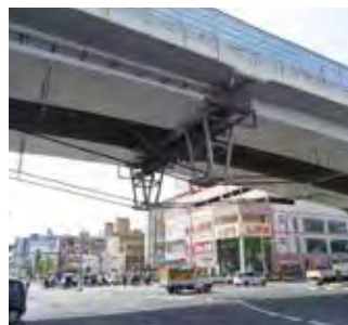
橋桁の中央付近が設計時の想定よりも大きく沈下
