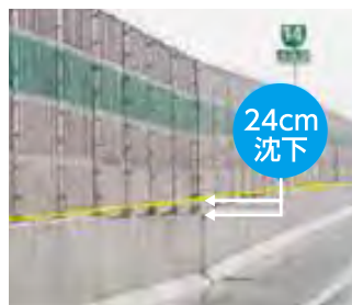
橋桁の中央付近が設計時の想定よりも大きく沈下
