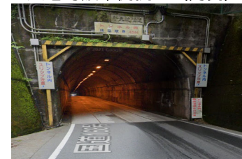
大塔町阪本側坑口（南側）
