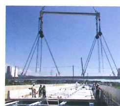
新しい床版の設置
