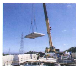
老朽化した床版の撤去
