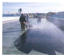
高性能床版防水の施工
