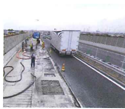
老朽化した床版の補修
