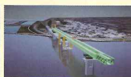
左：エレクションノーズによるプレキャストセグメント張出し架設
