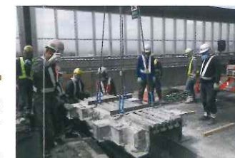
既存の伸縮装置を撤去
