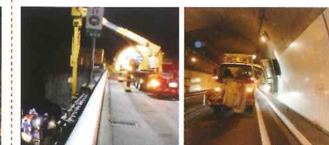
橋梁点検車を用いた橋梁下面および橋桁の点検 トンネルの側壁清掃
