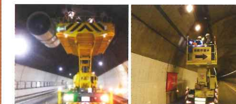
トンネルジェットファン点検 トンネル照明設備点検
