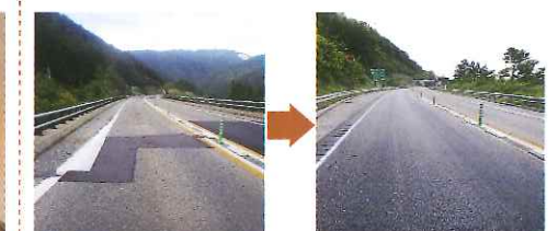
施工前 施工後
