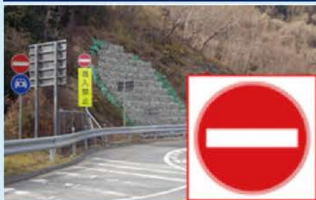
「この先進入禁止」の標識 (本線から一般道への流出ランプ)
