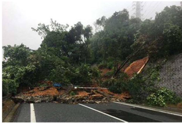
⑬ 九州自動車道 新門司 IC～小倉東 IC(上下線) 切土のり面崩落 お客さまへの被害なし
